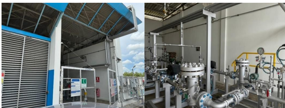
ภาพที่ 2 การเข้าสำรวจสถานีก๊าซธรรมชาติ
